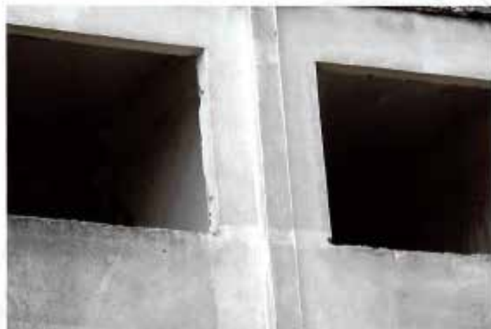
VISTA PARCIAL DO IMÓVEL – APARTAMENTOS SIMPLES – IDADE APARENTE 20 ANOS
