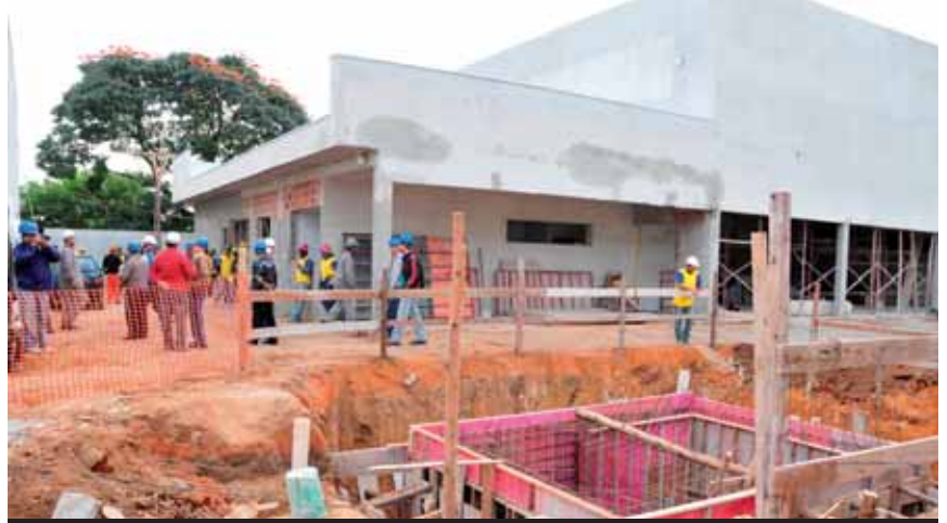
Representantes da comissão e moradores da região leste visitaram a obra
