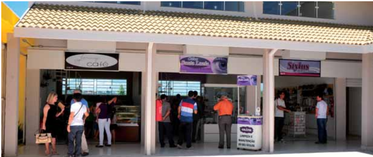
A unidade do Putim, que já está em funcionamento
