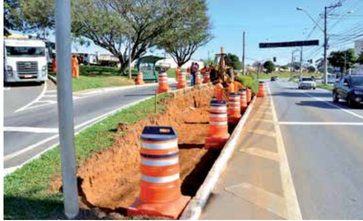
Foram realizadas obras no trecho para implantação da faixa exclusiva
