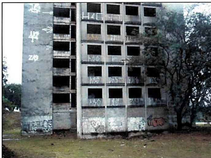
Vista da fachada oeste
