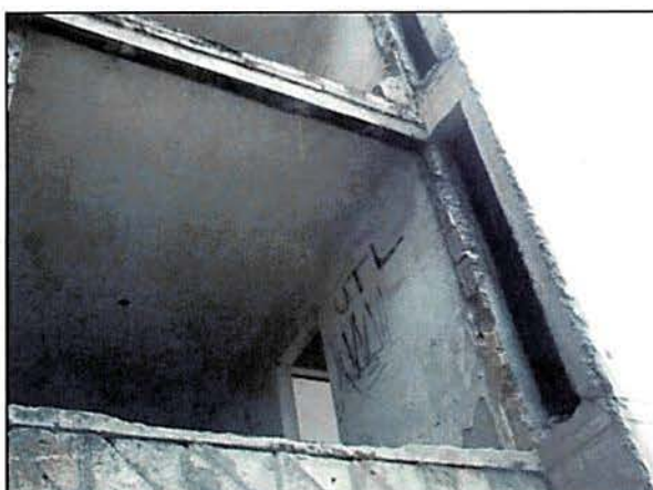
Vista interna da unidade habitacional
