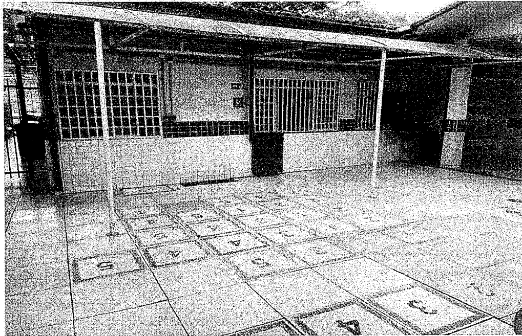
Vista interna do imóvel
