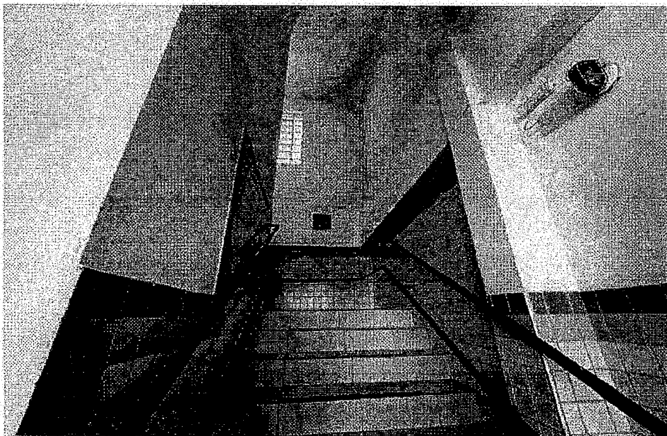
Vista interna do imóvel
