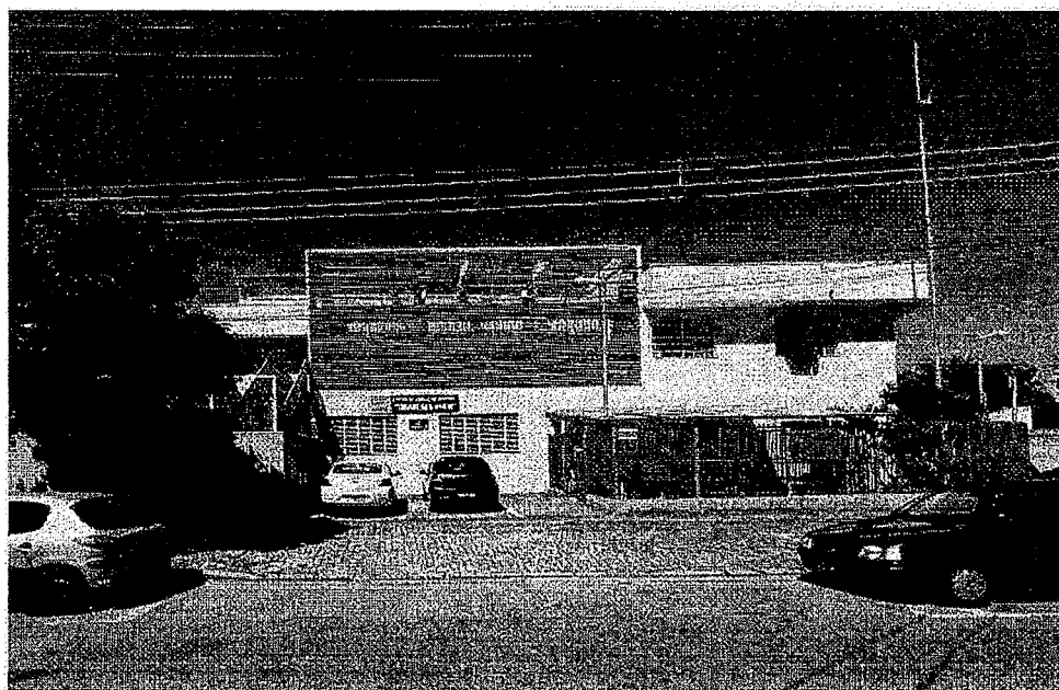
Vista da testada do imóvel.
