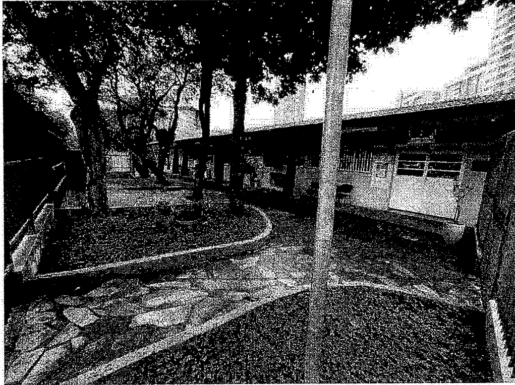
Vista do imóvel
