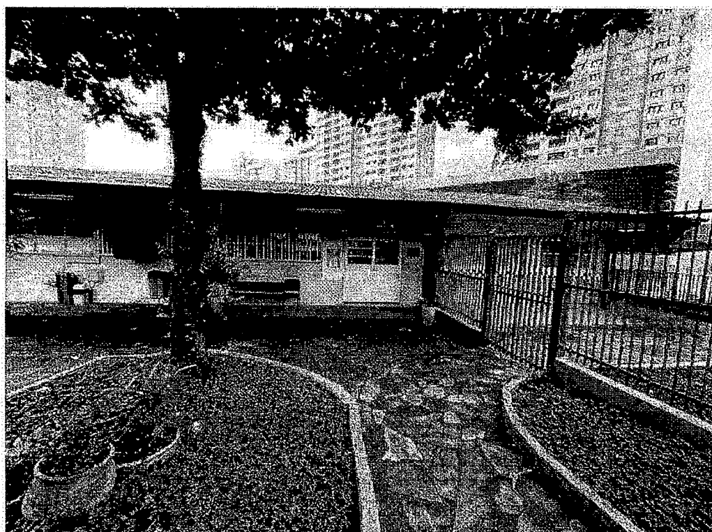
Vista do imóvel
