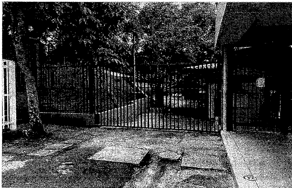
Vista da entrada do imóvel
