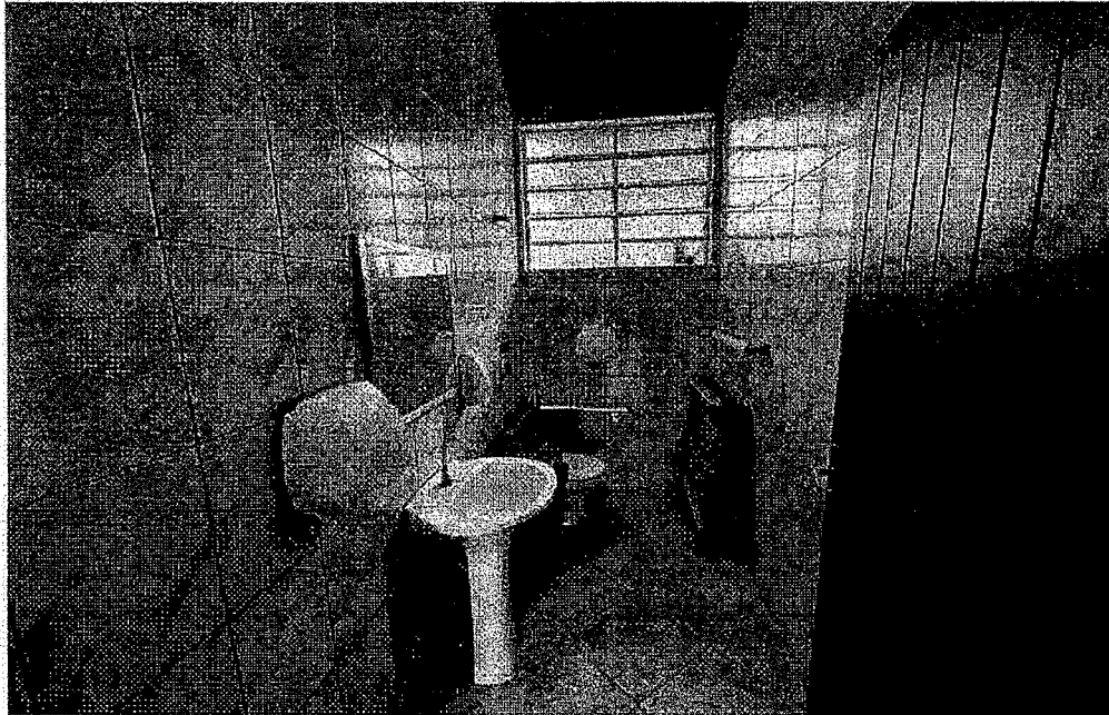
Vista interna do imóvel
