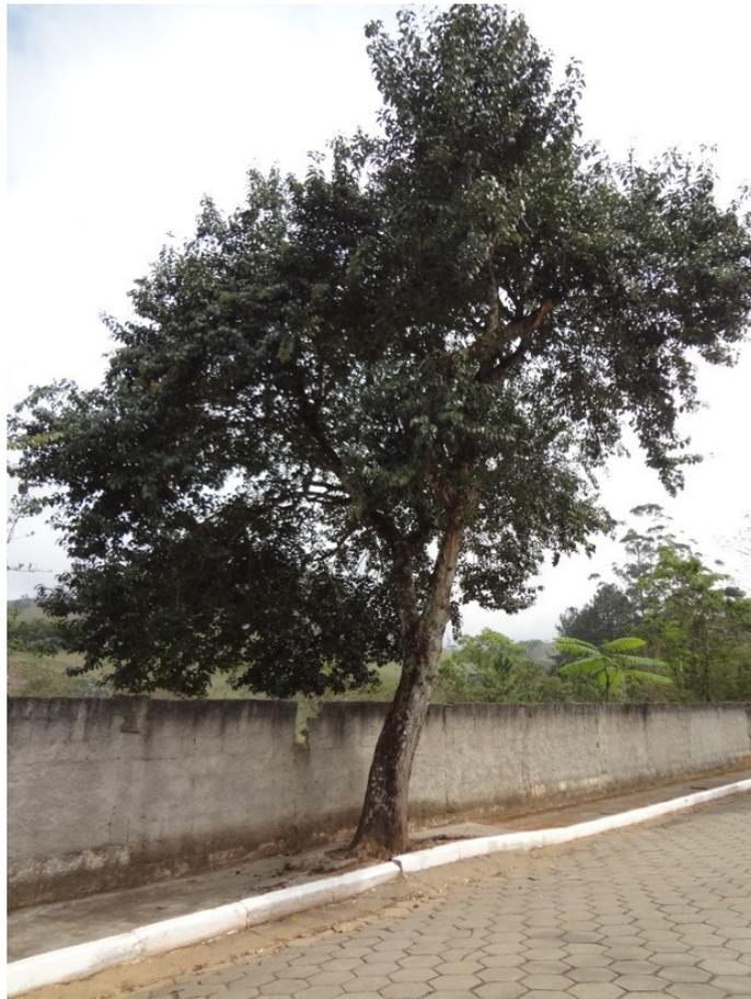
Figura 65 - Calçada pequena e levantamento de pavimento pela raiz da árvore Alfeneiro em SFX
