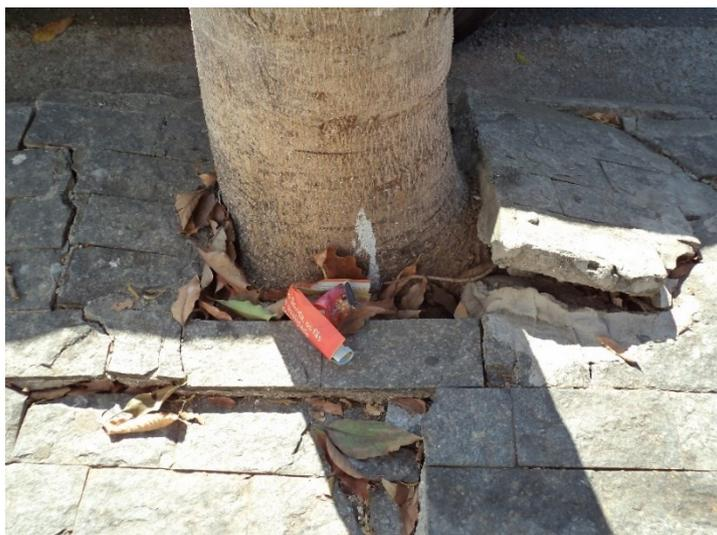
Figura 43 – Colo pavimentado e calçada danificada devido ao levantamento da raiz
