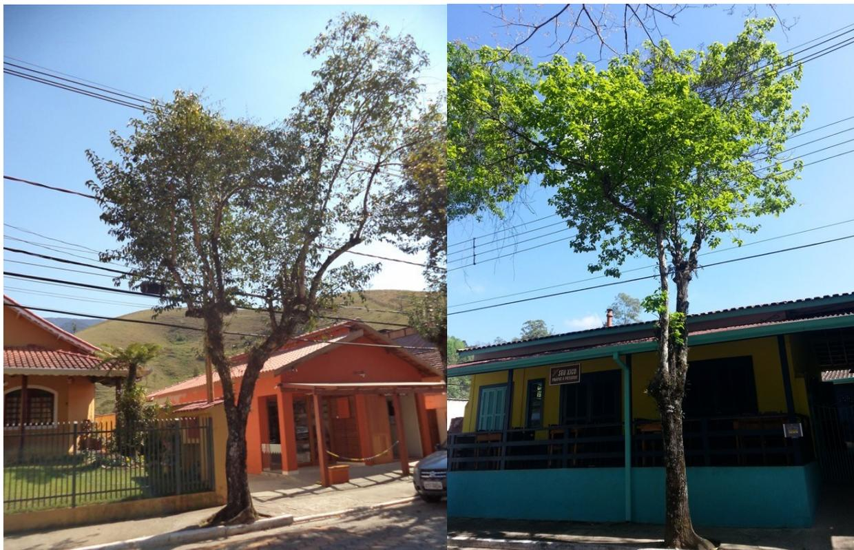
Figura 64 – Árvores em contato com a fiação nas vias públicas de SFX
