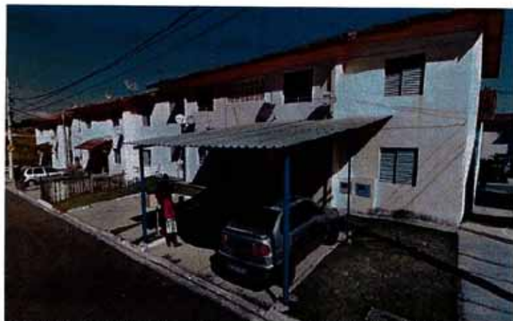
Foto nº 2 – Vista da fachada das unidades sobrepostas, dos BLOCOS 54, 64 e 74.
